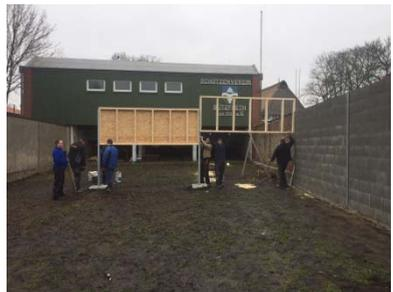
Am 27. August 2016 wurde mit dem Abriss der mittleren Felder und der Hochblenden begonnen. Nach dem Abriss konnten wir dann die Substanz des Fundamentes in Augenschein nehmen. Das Resultat fiel für den Schützenverein positiv aus. Wir konnten auf dem vorhandenen Fundament mit dem Neubau der Wand beginnen.
